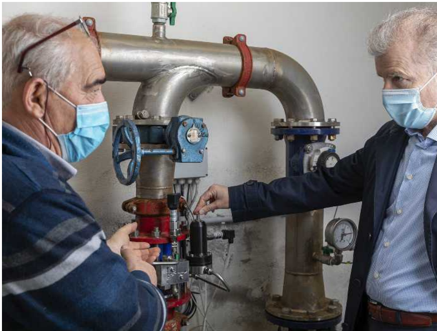
Antonio Gualtieri (l.), technischer Manager für Wasserleck-Erkennung bei IRETI, und Marco Alberti nehmen an einem Druckregelventil die Feinabstimmung vor.
